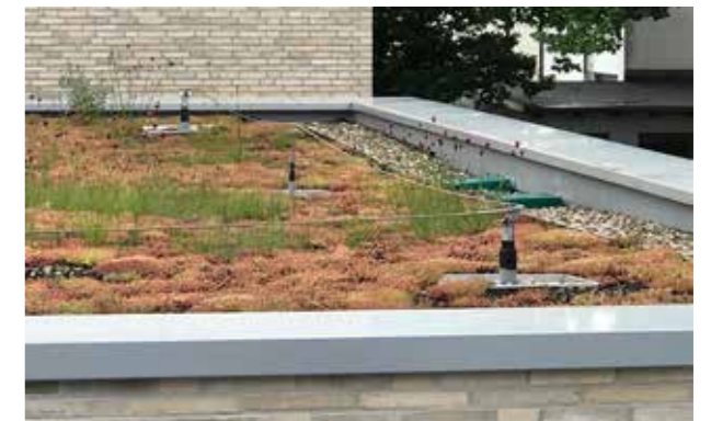
Dachbewuchs ERLEBNIS KIRCHE St. Johannes
